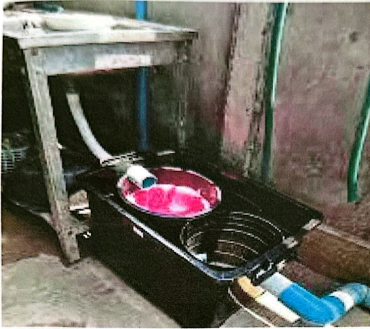
ติดตั้งไขมันอย่างง่าย
